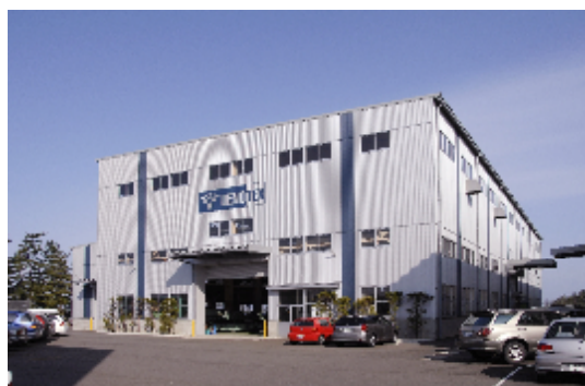
第1工場(大型工場)
